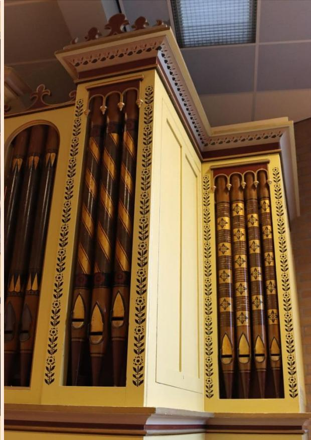
De orgelkas werd in 2000 technisch gerestaureerd waarbij delen van later aangebrachte verflagen werden verwijderd en originele details van versieringen en accenten opnieuw werden aangebracht.
