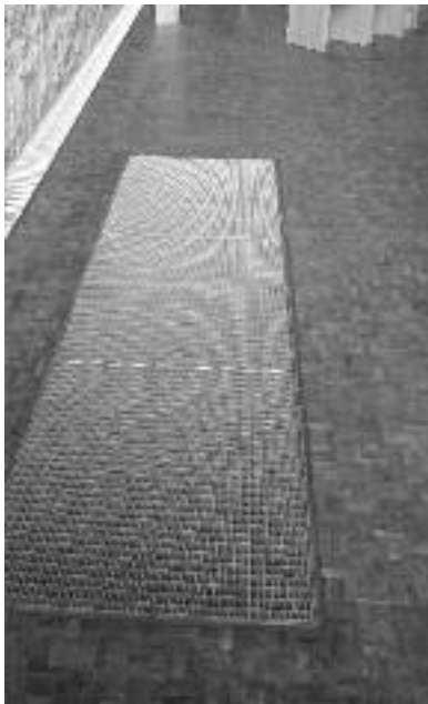
Heizungsschacht – Schallaustritt von „Vox de Profundis“
